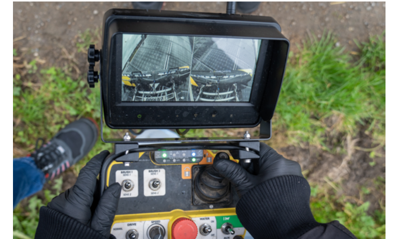
Sem trabalhos em altura: controlo remoto a partir do solo
